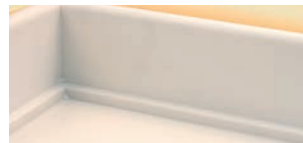
Fräsen der Verbindungen von Mineralwerkstoffen
